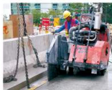
Road Sawing 馬路面切割
