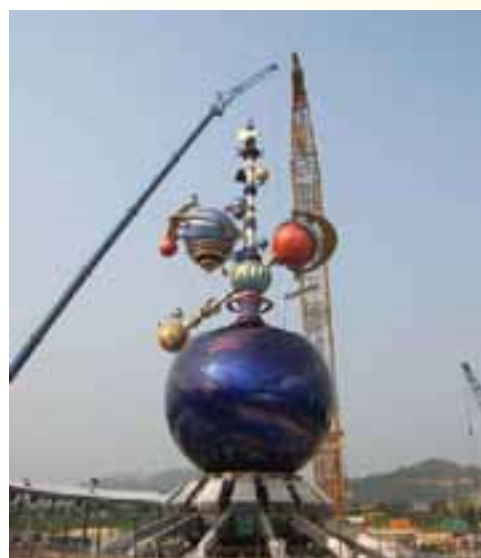
機動遊戲機安裝
