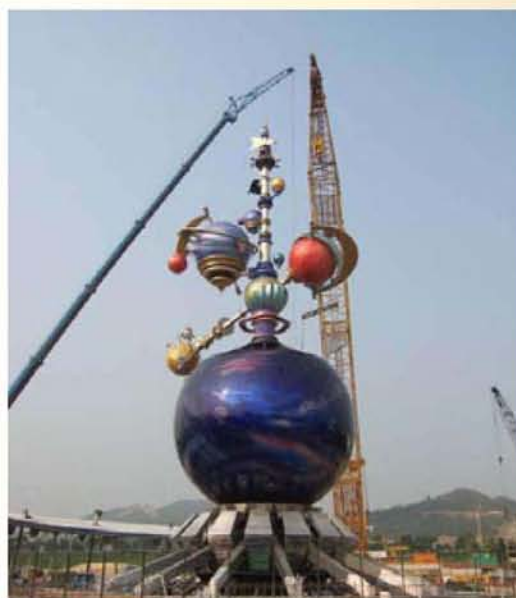
機動遊戲機安裝
